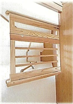
転落防止柵(階段降り口)
