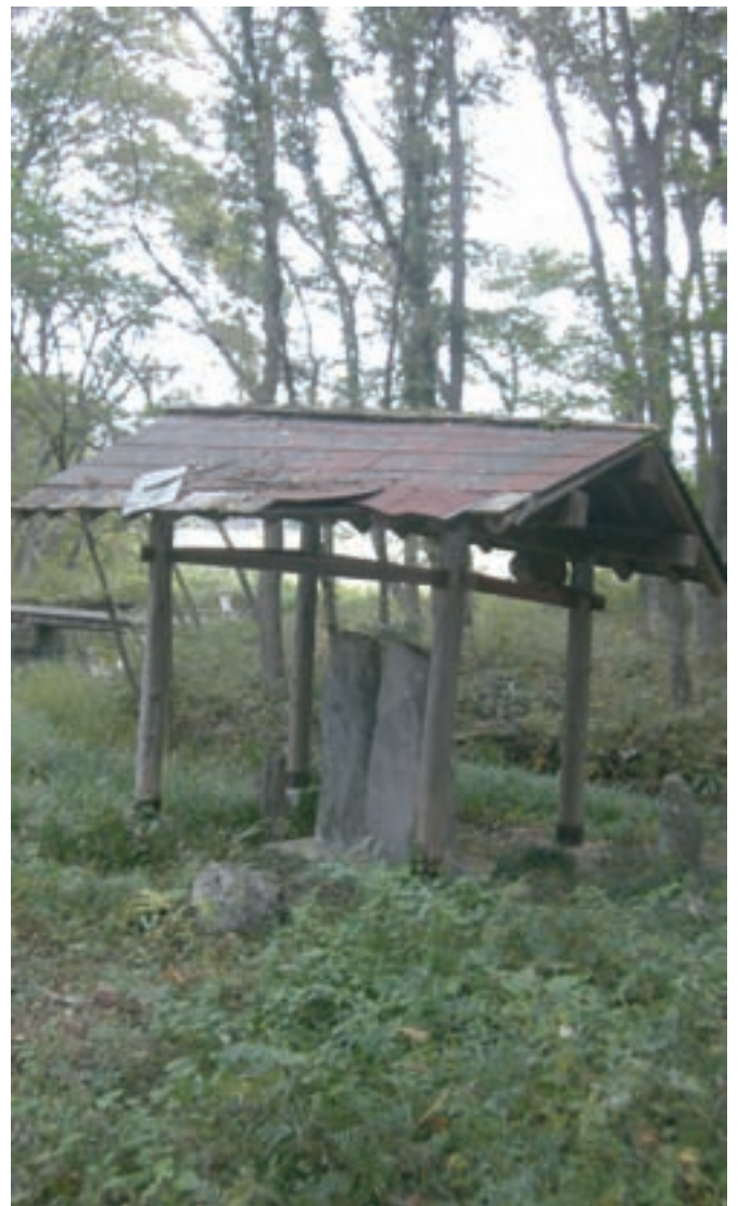
修繕求められる玉ヶ池
