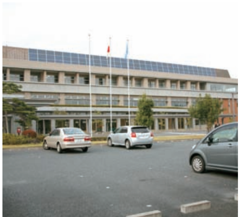
屋根いっぱいの太陽光発電（富谷町役場）
