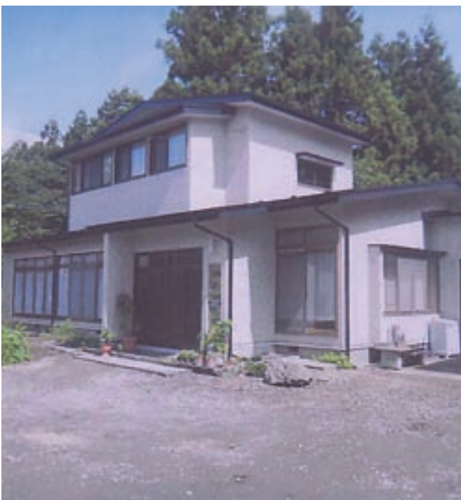
リフォーム着工後
