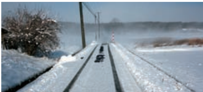
道幅のせまい町道柿ノ木線
