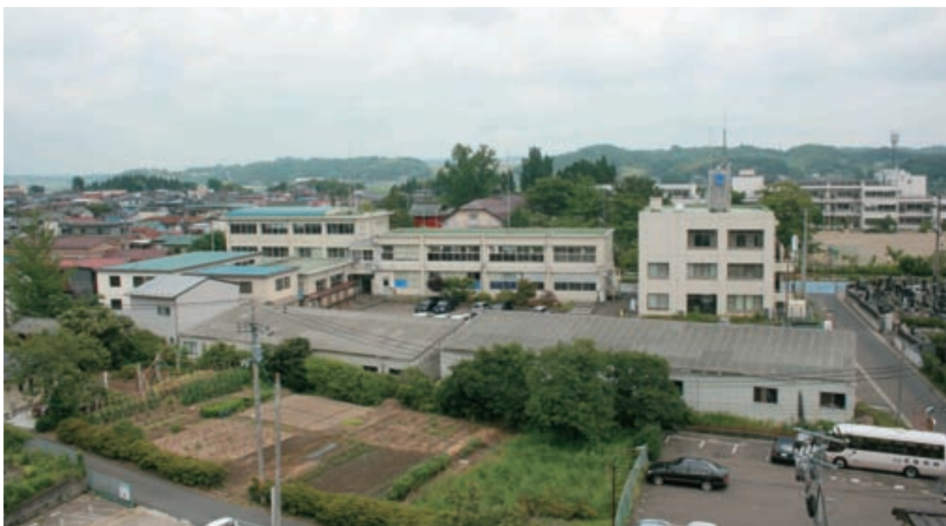
間もなく解体する旧庁舎
