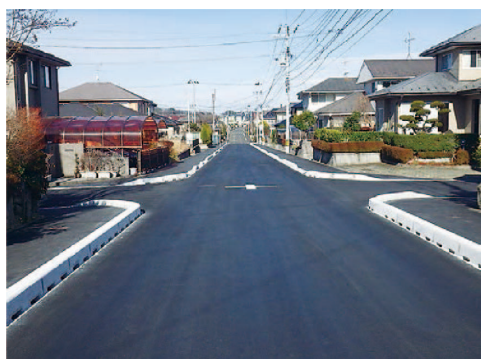
町道もみじヶ丘幹線（整備済み区間）
