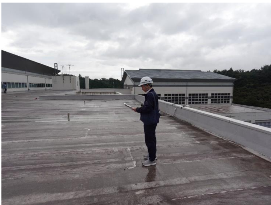
図. 2. 8-1 現地調査の様子（総合体育館屋上）
