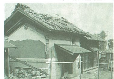
屋根瓦・土壁の崩落
